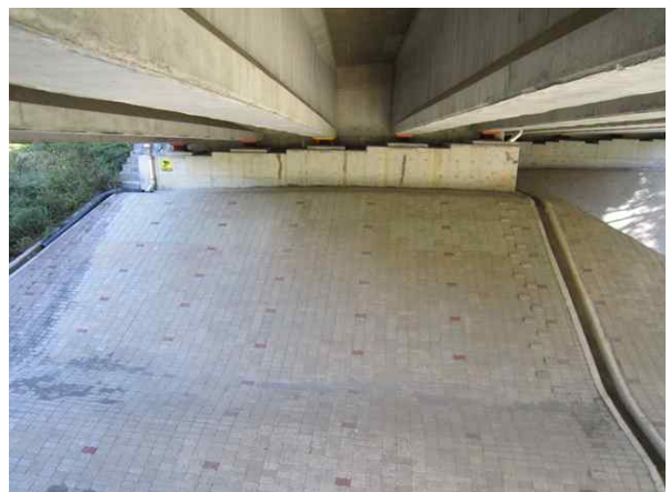
교량 하부 전경
