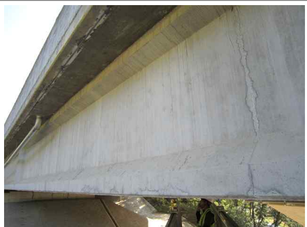
교량 거더 전경
