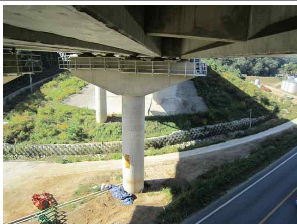
교량 하부 전경
